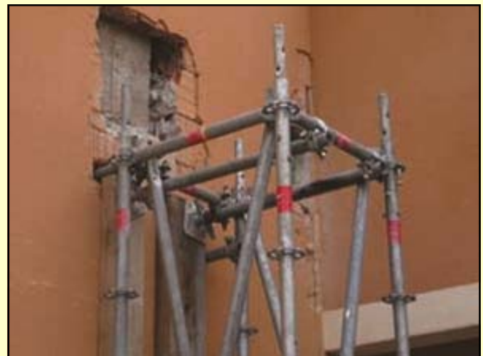
Structure des étais qui soutiennent le Centre Commercial place de Bans.
